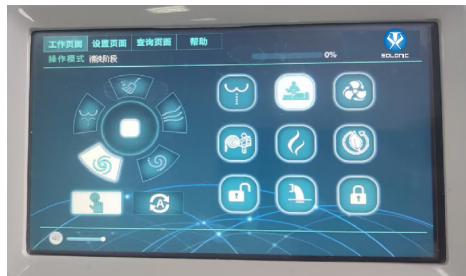
安裝完成執行1次手動大便流程
